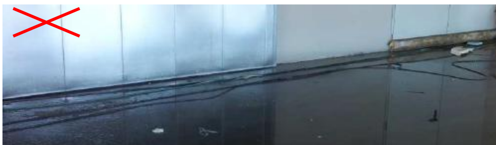
Tendido de conductores eléctricos en zona encharcada
